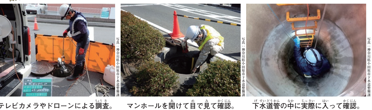
テレビカメラやドローンによる調査。マンホールを開けて目で見て確認。下水道管の中に実際に入って確認。
